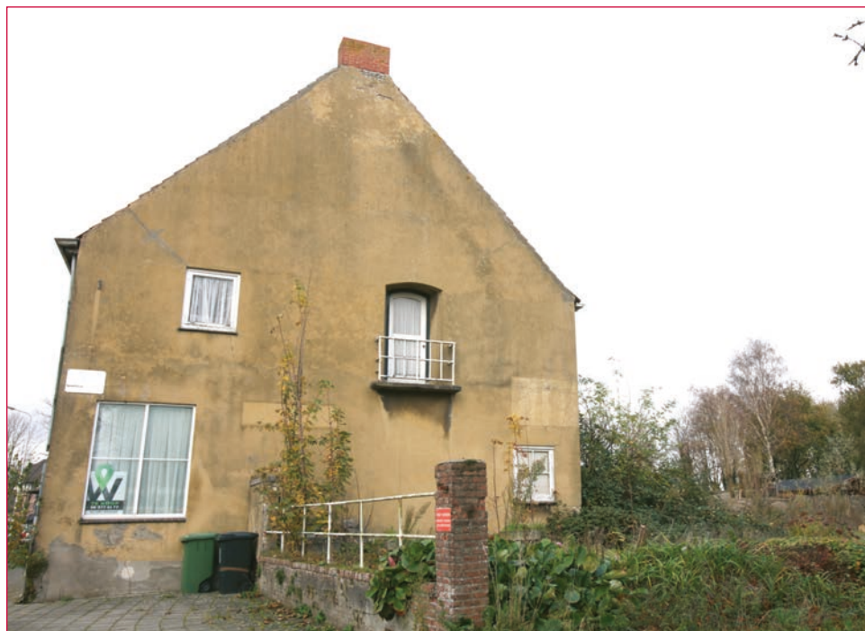
Het Burgergasthuis op het achterterrein is ten prooi gevallen aan de sloophamer.
